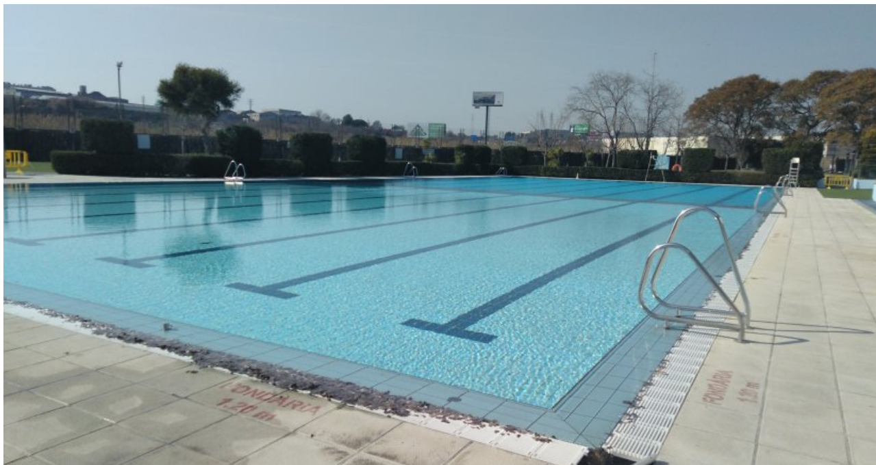
Piscina del Poliesportiu Municipal de Ripollet
