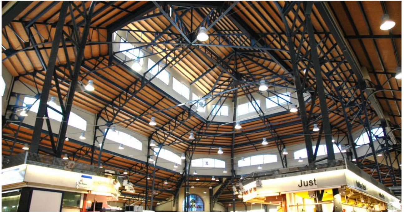
Coberta del Mercat Central de Sabadell © Viquipèdia
