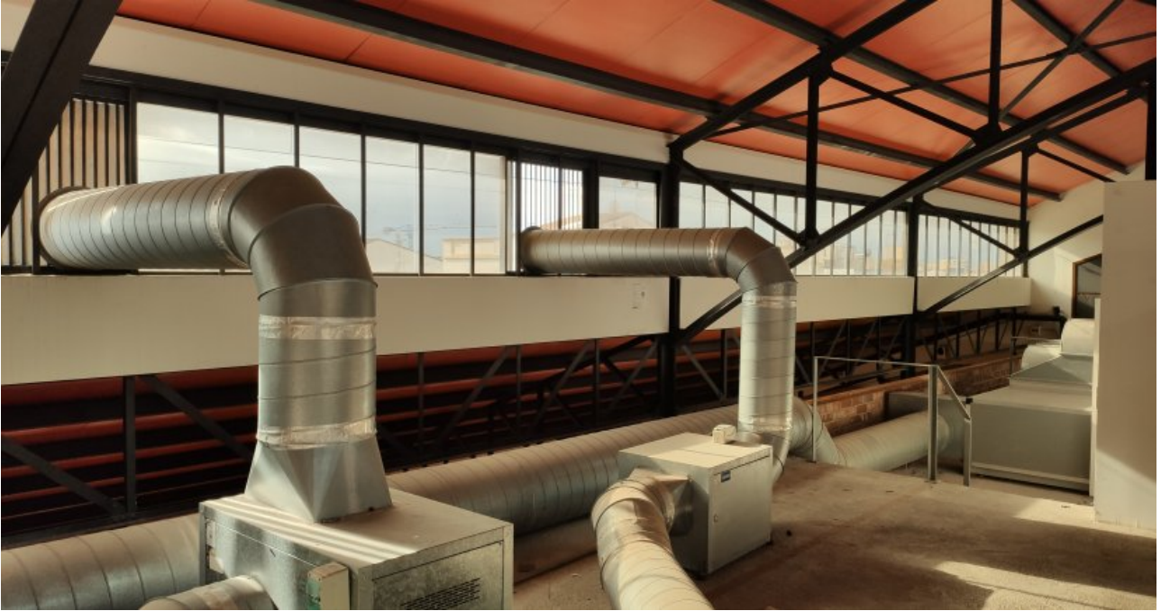
• Detall de la coberta del mercat de Mataró © Elaboració pròpia
