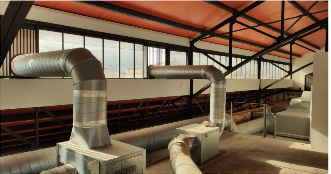
Detalle de la cubierta del mercado de Mataró © Elaboración propia
