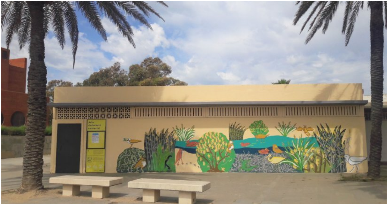
Fachada del Aula Ambiental © Ayuntamiento de Sant Adrià de Besòs
