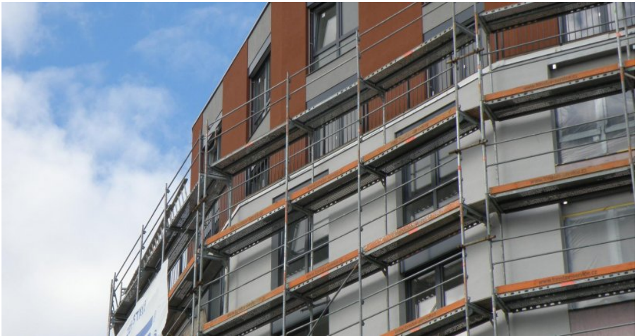
• Aislamiento exterior en un edificio © Pixabay
